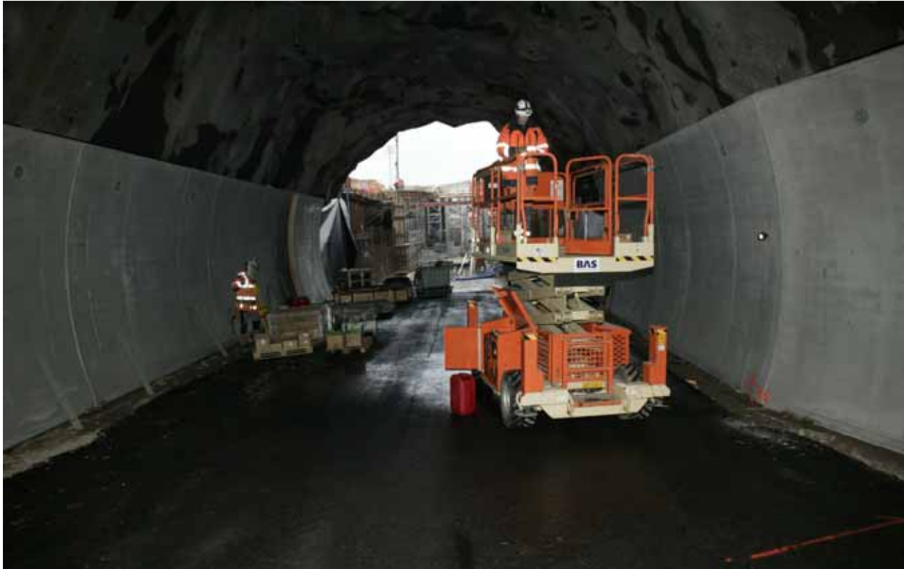
Montering av veggelementer i Bjølstادتunnelen. (foto: Glemmen vgs.)
