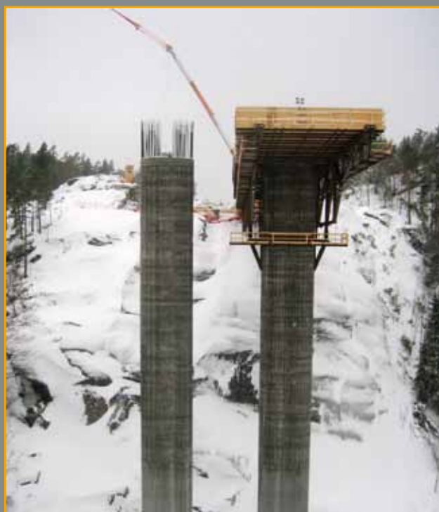
Søyler Kjøseveien bruer
