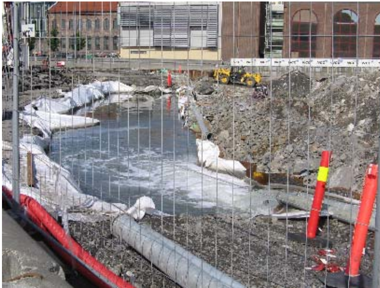
Figur 6 Sedimentasjonsbasseng på utside av spunt, Havnelageret, 12.07.06.
