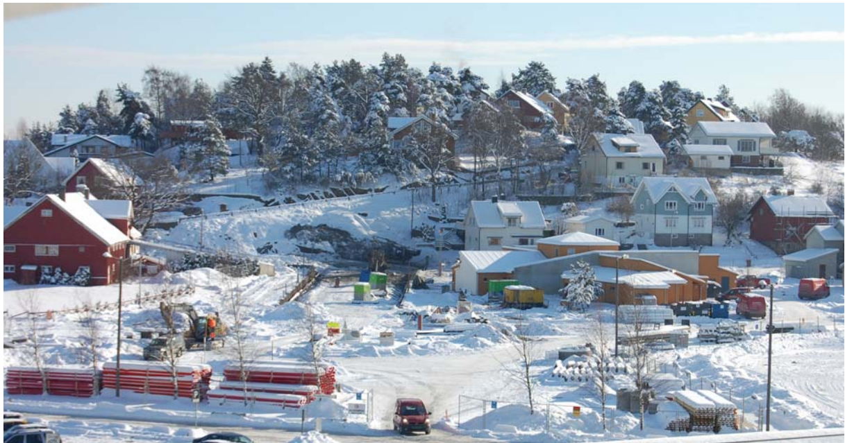
Snø på anleggsområdet 13.02.2009. Tunnel-påhugget kommer mellom spuntrekkene i midten av bildet. Sarpsborg Park- og Anlegg holder til i gamle Kråkeby barnehage (gult bygg).
