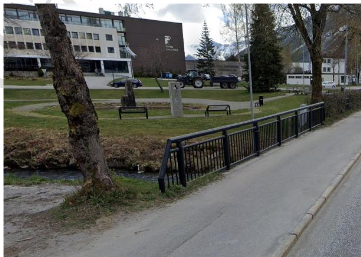
Figur 3-10: Eksempel på avslutning av bybrurekkverk
