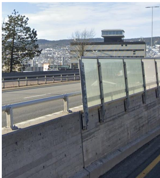
Figur 4-4: Eksempel på støyskjerm montert på ikke-ettergivende rekkverk
