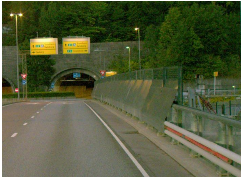
Figur 4-8: Eksempel på rekkverk utformet etter alternativ b)
