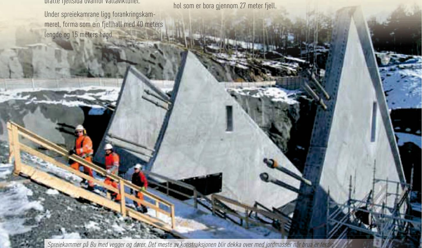
Spreiekammer på Bu med vegger og dører. Det meste av konstruksjonen blir dekka over med jordmasser når bruа er ferdig.
