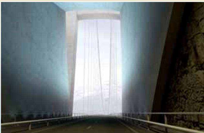
Hardangerbrua blir den lengste hengebrua i Norge. Ho skil seg ut blant dei norske hengebruene med tydelege arkitektoniske grep. Tårnhusa med 15 meter høge, spisse avslutningar over tårnsadel er kombinert med ekstra høge tunnelmunningar på båe sider av fjorden. Fram mot vidaduktene på bru stig tunnelopninga med eit nytt løft gjennom tunnelportalanane.
