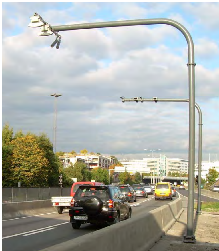
Figur 4.17 Automatisk bomstasjon med antenner, laserscanner og kamera
