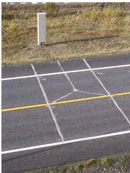
Figur 4.8 Nedfreste piezoelektriske kabler
