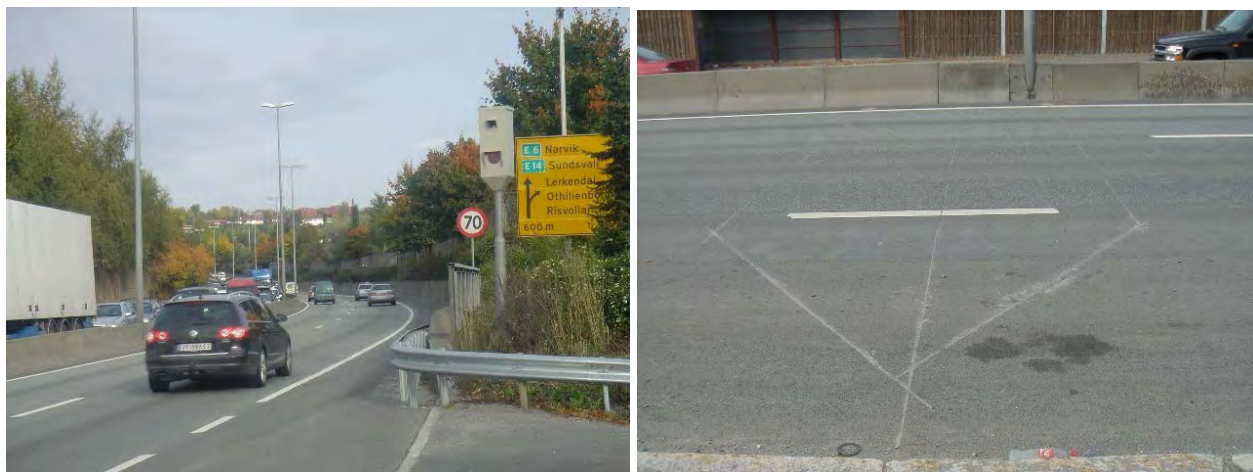
Figur 4.22 ATK-punkt med fotoboks og freste spor for detektorer
