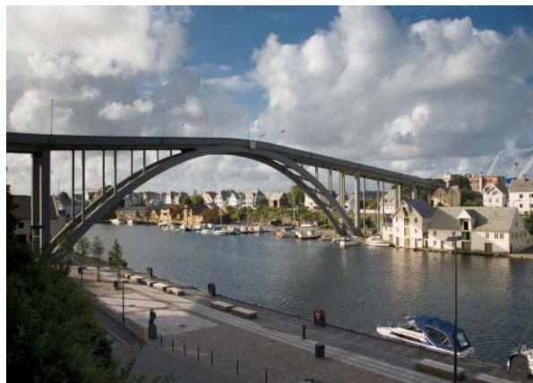
Risøy bru, Fv 47, Rogaland. Buebru i armert betong. Lengde 366 m. Hovedspenn 100 m. Byggeår 1939. Rehabiliterert 2005. Pris i 2008.
