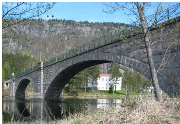
Åmfoss bru, Fv 278, Aust-Agder. Steinhvelv i to spenn, hver på 41m. Lengde 94m. Byggeår 1918.
