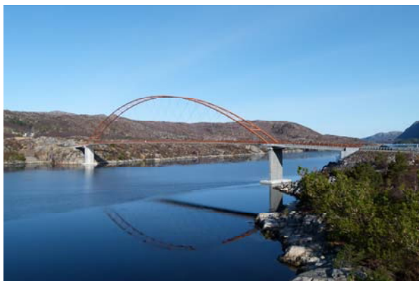
Brandangersundet bru, Fv 4, Sogn og Fjordane. Nettverksbue i stål med forspent betongdekke. Hovedspenn 220m. Lengde 285m. Byggeår 2010.
