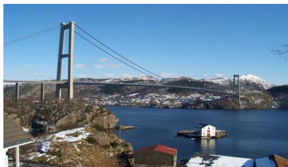
Askøybrua, Fv 562, Hordaland. Hengebru med hovedspenn på 850m. samlet lengde 1057m. Byggeår 1992.
