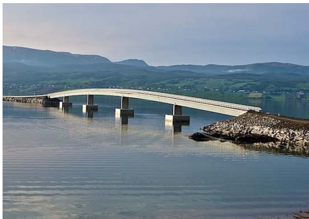
Kveøybrua, Fv 105, Troms. Stål kassebærer i 5 spenn med armert betongdekke. Lengde 370m. Hovedspenn 80m. Byggeår 2010.
