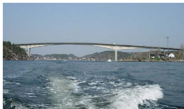
Vrengen bru, Fv 308, Vestfold. Fritt-frembygg bru i spennbetong. Lengde 465m. Hovedspenn 171m. Byggeår 1981.
