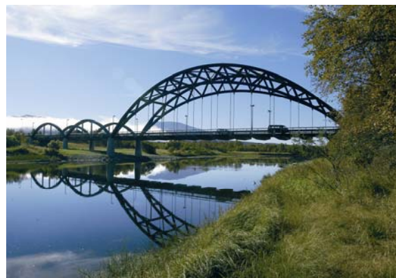
Tynset bru, Fv30, Hedmark. Buebru i tre i 3 spenn. Lengde 125m. Hovedspennet er en fagverksbue på 70m. Byggeår 2001.
