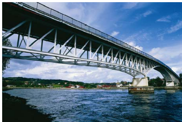
Straumen bru, Fv 775, Nord-Trøndelag. Fagverk i 3 spenn med innhengt betongplate. Lengde 203m. Hovedspenn 72m. Byggeår 1958.
