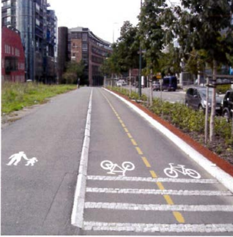
Figur 8.24 Eksempel på bruk av 1037 "Gangsymbol"
