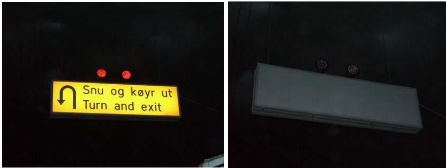
Figur V6.1: Eksempel på skilt og signal for snunisje i tunnel. To-posisjonsskilt vist i aktiv og passiv stilling [24]
