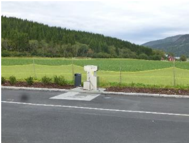
Tømmeanlegg i Kvithammar, E6. Foto: Guri Pedersen Skei
