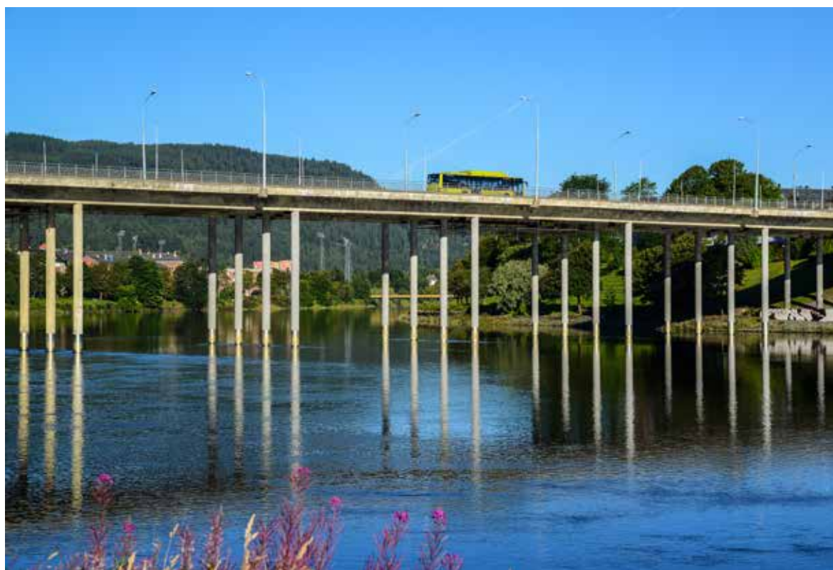
Buss på Elgeseter bru over Nidelva i Trondheim. Foto: Knut Opeide
