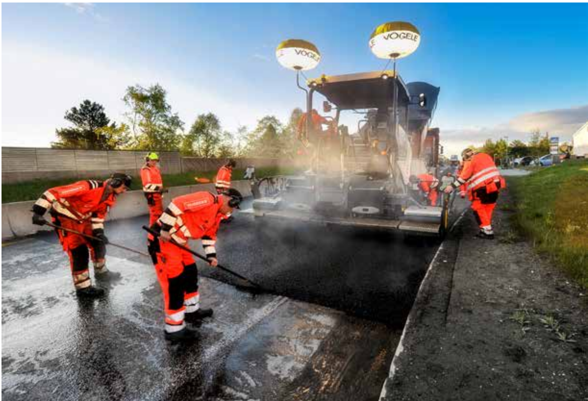
Asfaltering E6 Omkjøringsvegen. Foto: Knut Opeide
