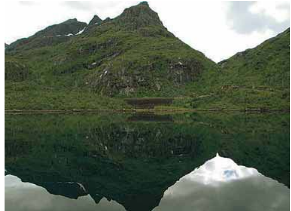
Svartskarvika (Lofast). Her er bygget en 37,5 grader bratt skråning kledd med vekstmasser lagt rett på steinfylling. (Foto Jan Fredrik Eliassen) (fra Vegen og vi 14/07)
