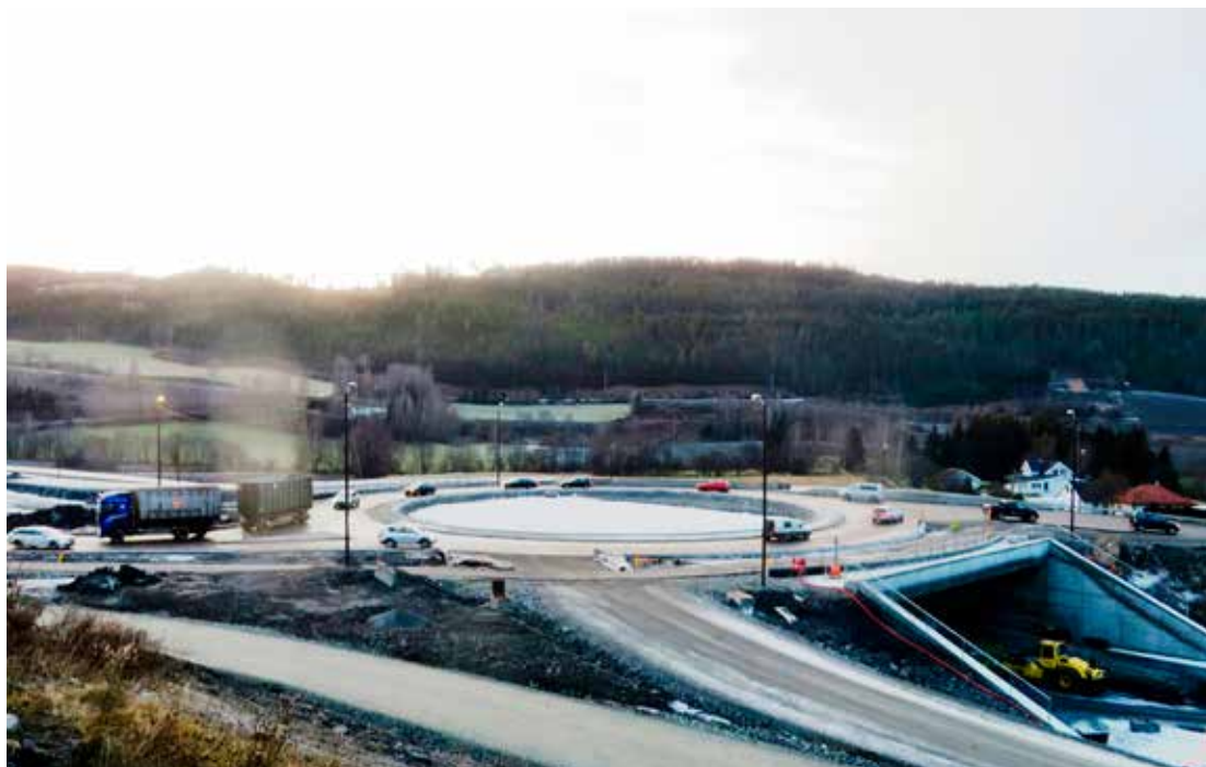
Arbeidet med selve konstruksjonen i Morstad kulvert er ferdig og i begynnelsen av desember ble trafikken lagt om slik at trafikantene nå kjører over Morstad kulvert slik vi ser på bildet. Foto: Per Olav Tangen
