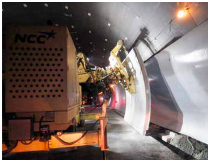
Montering av vegg inne i tunnelen forbi Gran sentrum
