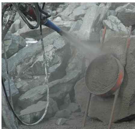
Eksempel på sprøyting av første av totalt tre plateprøver fra samme betonglass. Gjennomsnittet fra tre plateprøvinger i laboratoriet er ett prøvningsresultat for aktuell fibermengde og fasthetsklasse. Foto: Øyvind Bjøntegaard
