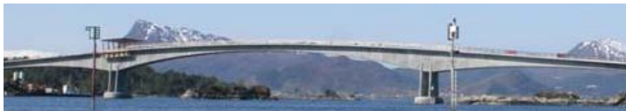
Bilde fra Eiksundbrua som har tilsvarende dimensjoner i hovedspenn.
