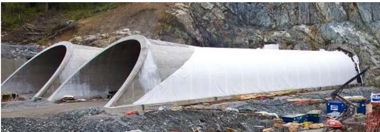
Eksempel på portal på 4-felts veg før tilbakefylling
