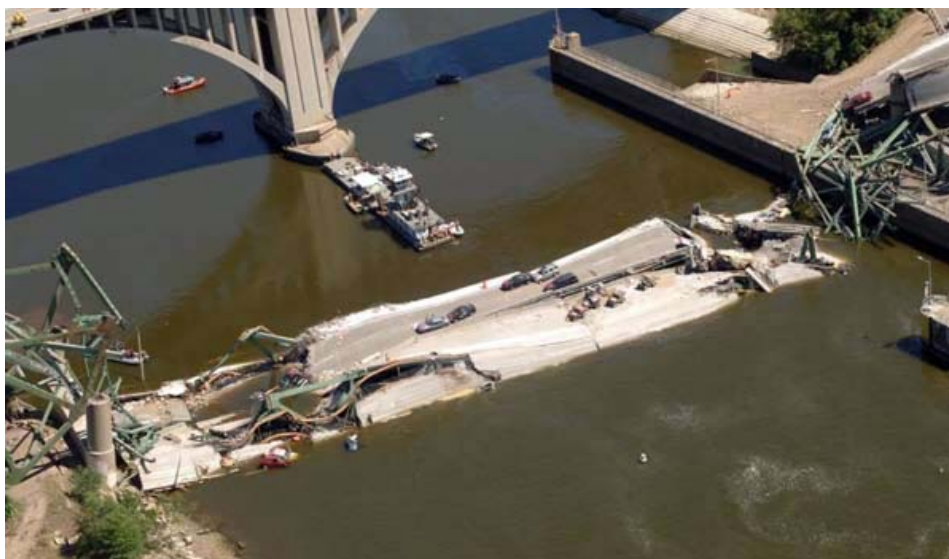
Foto: Kollapset hovedspenn i Mississippi river med kjøretøy på brudekket.
