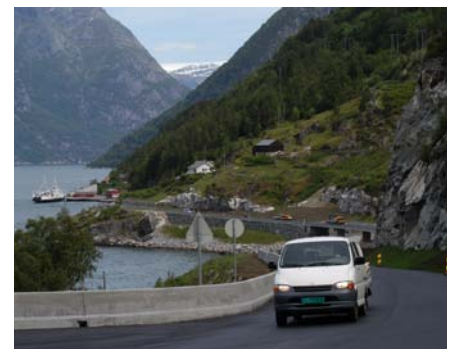
Første byggjesteg på utbetnings- og rassikringsprosjektet Bu-Brimnes er ferdig denne sommaren. (Foto: Geir Brekke)
