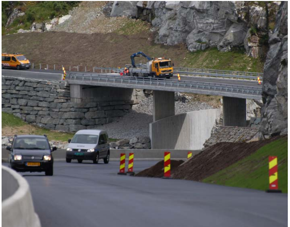
Det blir god plass til framtidige skred under Storagjelbrua. (Foto: Geir Brekke)
