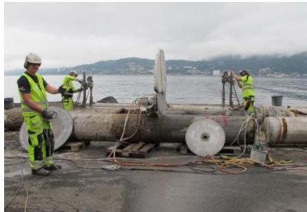
Utboring av kjerner og saging av midtdelen av betongsøyler (utført av Sørheim Riveservice) (foto: Tobias Danner)
