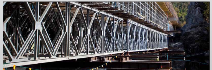
Forskaling ved støping av betongbruer tar stor plass og sperrer hele seilingsløpet. Dette er grunnen til at det blir helt stengt vinteren 2017/2018.
