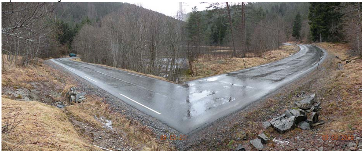
Figur 2 Del av tellestrekning uten ledegjerder. Venstre del av bildet er tatt mot øst, høyre del mot vest. Litjevatnet i bakgrunnen
