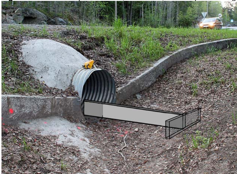
Figur 8 Amfibietunnel på Skoklefall, Nesodden, med T-sperre inntegnet
