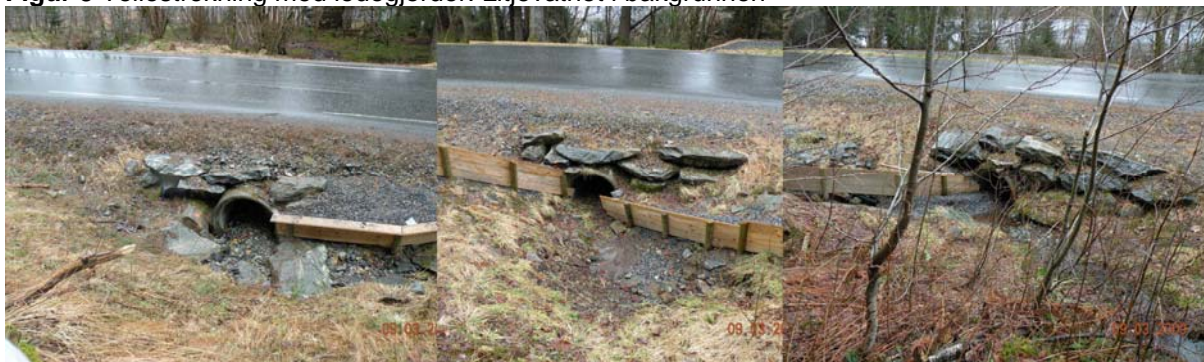
Figur 3 Tellestrekning med ledegjerder. Litjevatnet i bakgrunnen
