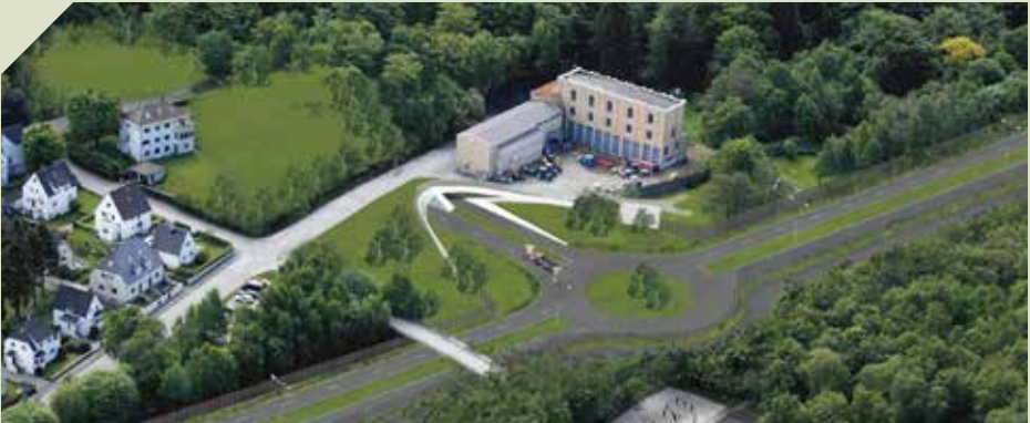
Ved Gamlingen bygges ny rundkjøring med arm til Hundvågtunnelen.
