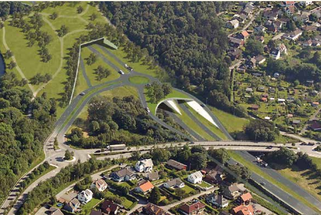
Eiganestunnelen starter på Motorveien ved Schancheholen/Våland kolonihage
