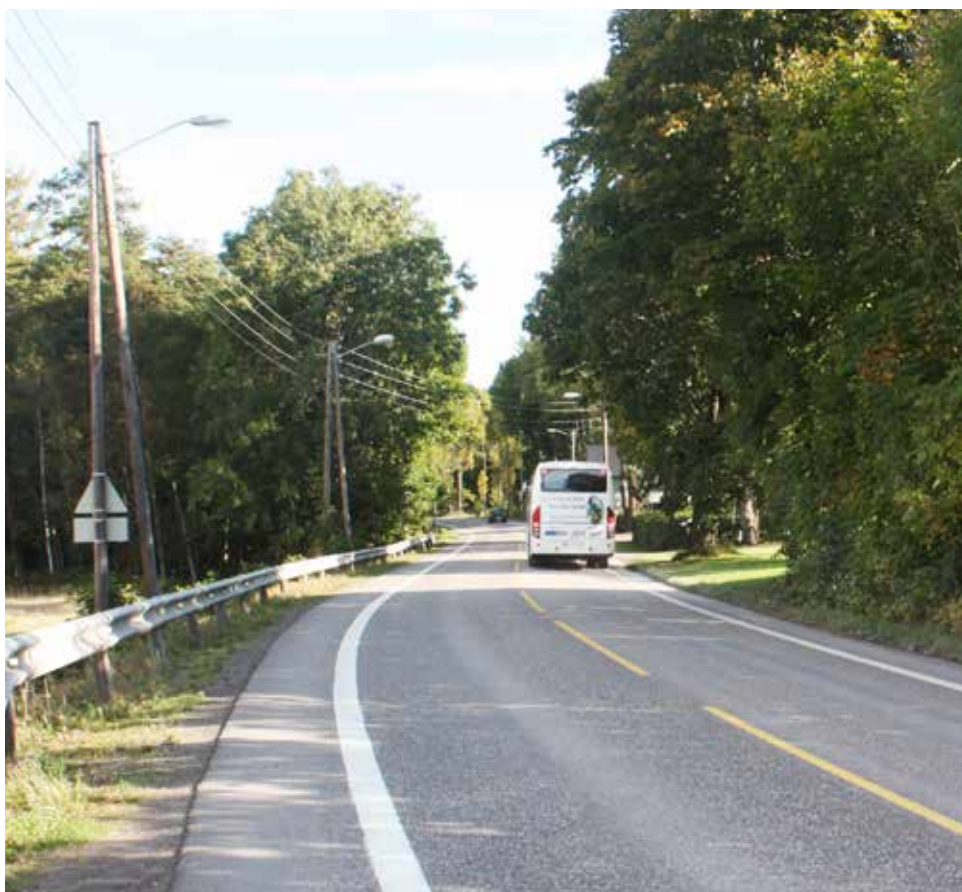
Gang- og sykkelveg etableres på venstre side.
