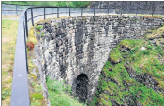
Jøl bru i Hjelledalen, eit unikt byggverk.
