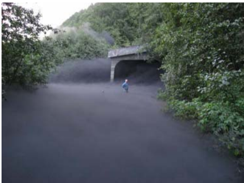
Figur 32 Konsekvens av redusert ventilasjon, medførte kald røyk ved utløpet
