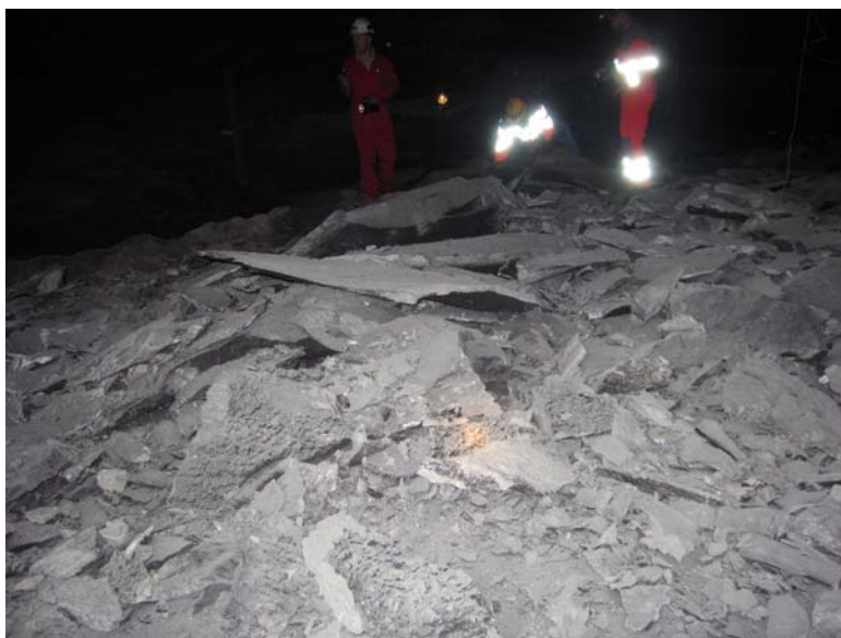
Figur 22 Nedfall 10 m nedstrøms
