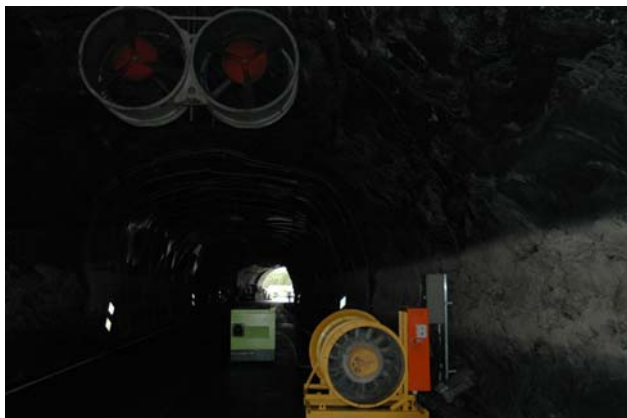
Figur 2 Fastmonterte og mobil vifte
