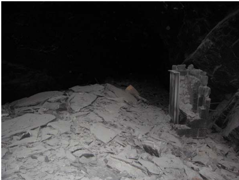
Figur 23 Nedfall 10 m nedstrøms ved vegg
