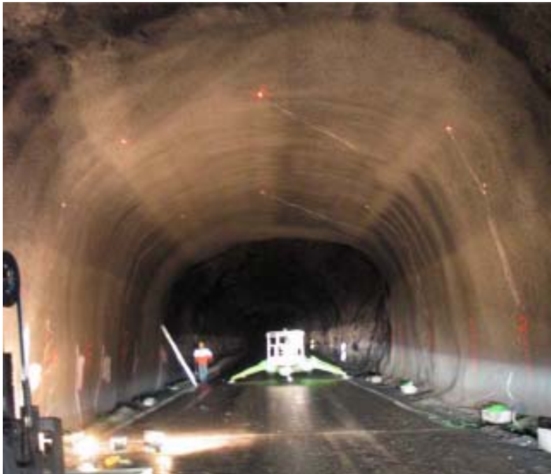
Figur 28 Sprøytebetongkonstruksjonen før varmeeeksporing
