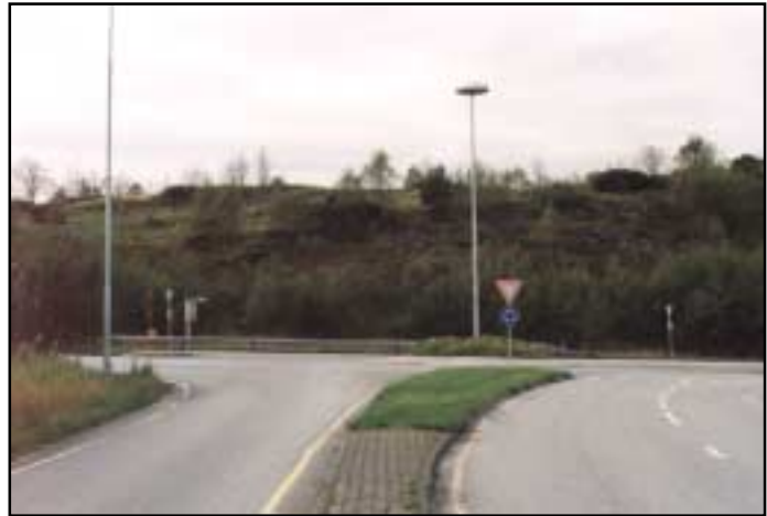
Tunnelpåhugg ved Smiene (foto: Skjold Sægrov Torpe/Torbjørgh Sægrov)
