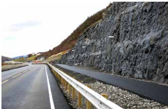
Oppgradert veg og ny gang- og sykkelveg ut fra Mosjøen. Foto: Gunnar Nilsen
