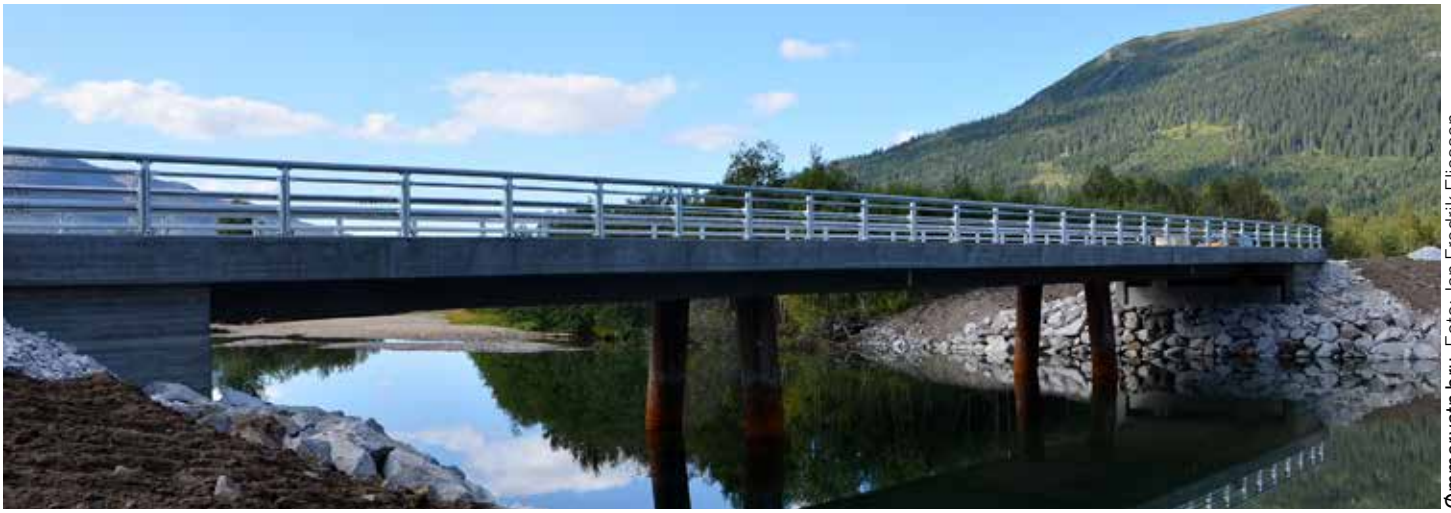
Ømmervatn bru. Foto: Jan Fredrik Eliassen
