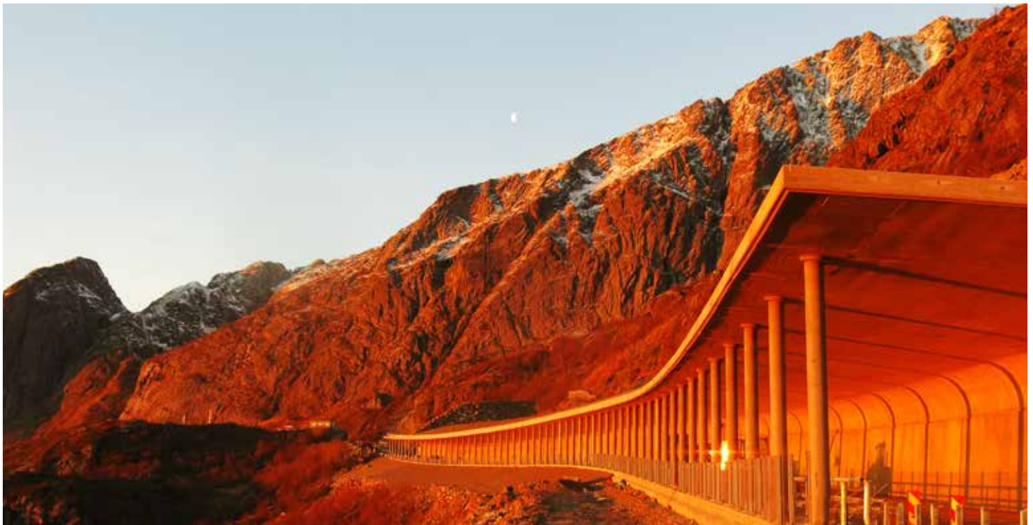
Det er bygd 955 meter med rasoverbygg.
