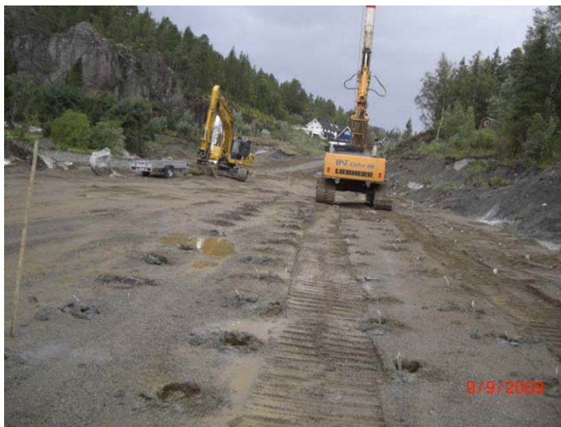
Figur 8: Eksempel på setting av PVD dren i rasgropa etter Kattmarkaskredet, Namsos
