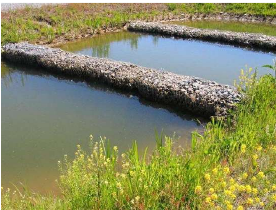
Sedimentasjonsbasseng ved E16 Akershus, Skuitunnelen
