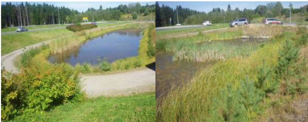
Sedimentasjonsbasseng ved E6 Akershus, avkjøringen til Kolbotn
