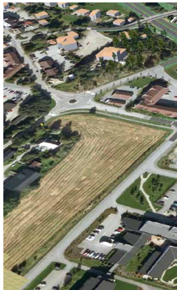
ØRJE FRA LUFTEN: I tillegg til oppgradering av E18 vil det skje en større omlegging av lokalvegene i Ørje sentrum. Reisende på fylkesvei 21 fra Halden til Rømskog skal ikke lenger ut på E18, men krysse motorvegen over Norgesporten bru.
