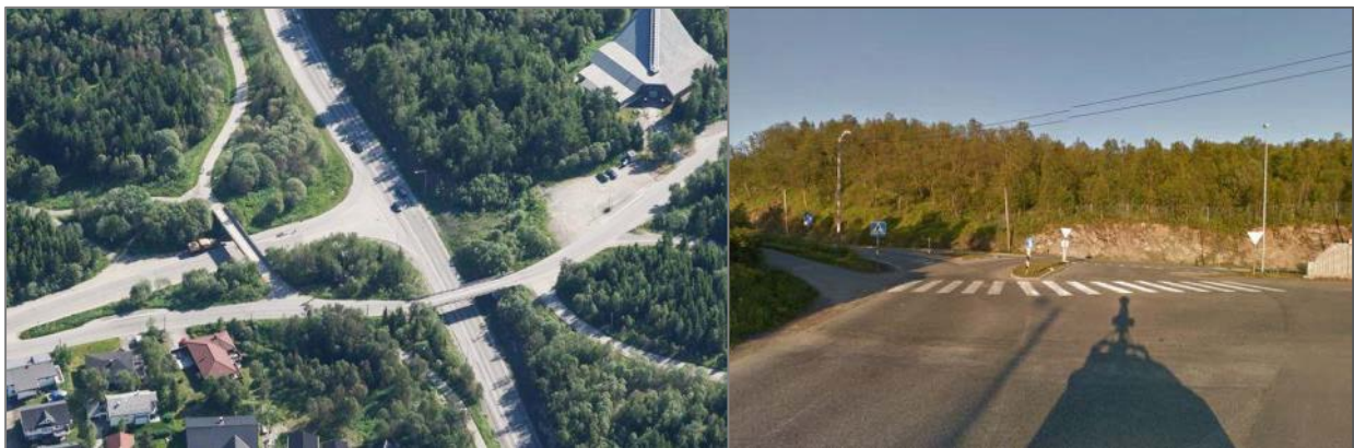
Eksempel på et trafikkfarlig vegkryss: kryss Erling Kjeldsens veg med Båtmannsvegen
