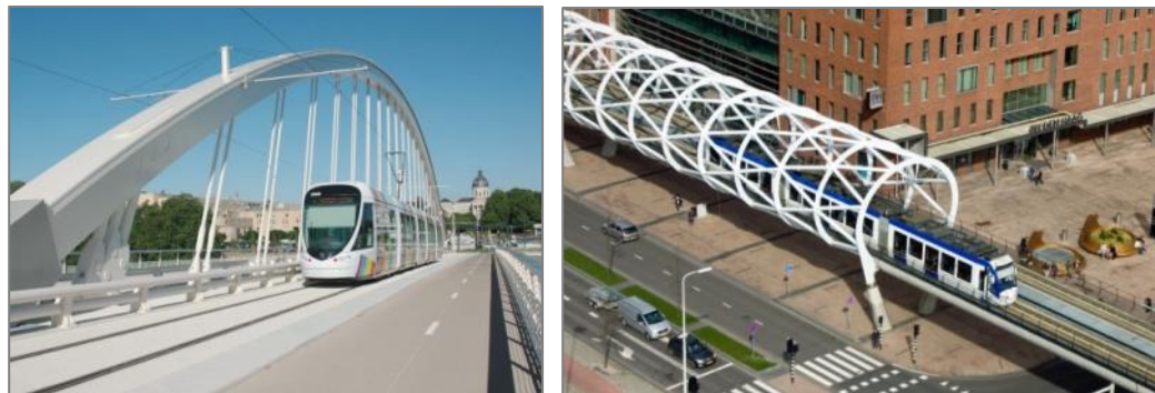
Bru for bybane, gående og syklister. Bru for bybane, Den Haag/Nederland. Angers/Frankrike http://bustram.irigo.fr
