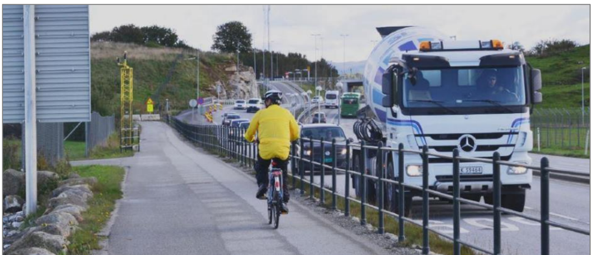
Sykkelveg atskilt fra biltrafikken med stabil autovern/rekkverk (Stavanger/Sola, Sømmevågen)
