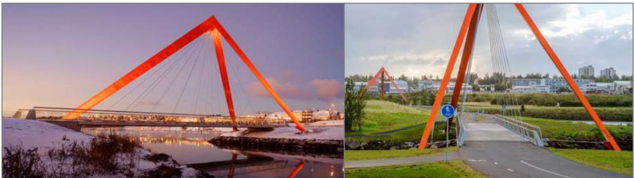
Gang- og sykkelbru, Reykjavik/Island. www.tst.is/verkefni/goengu-og-hjolabryr
