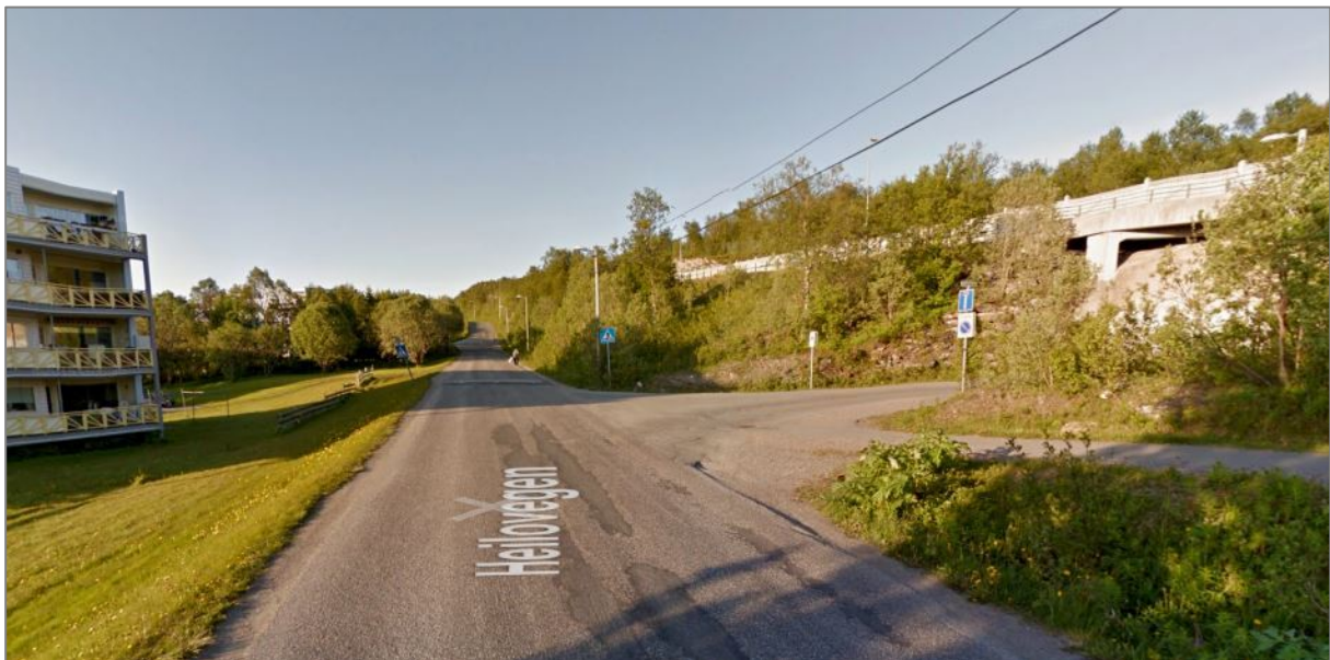
Mortensnes: boligbebyggelse til venstre, Heilovegen i midten og Erling Kjelsens veg opp til høyre
