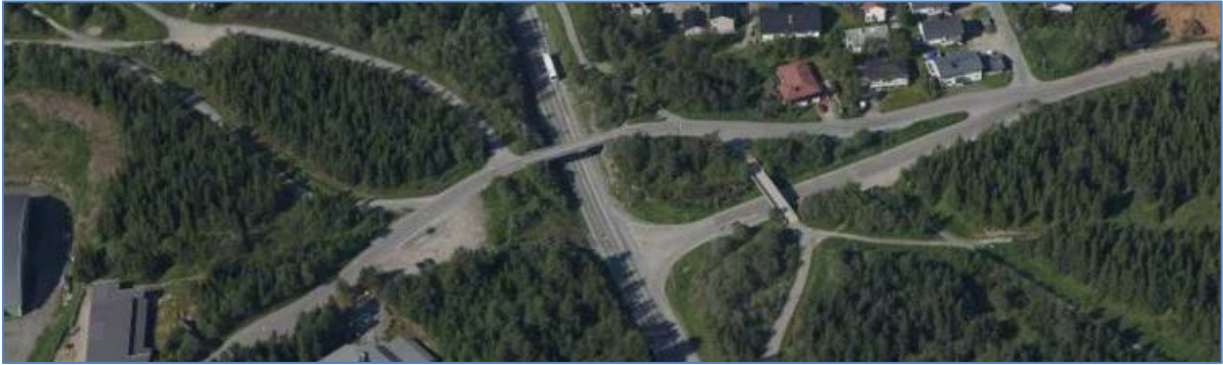
Dramsvegen ved Grønnåsen: tverrforbindelsen har en stor barrierenvirkning for turgåere og skigåere
