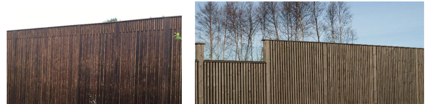
Figur 14. Eksempler på tette skjerm med variasjon i mønster og med avtrapping.
