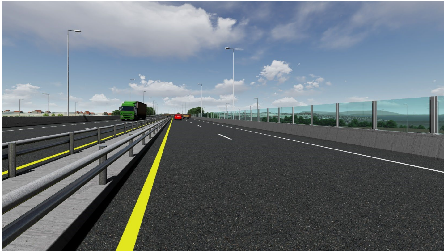
Figur 16. Illustrasjon fra 3D-modell viser hvordan bruk av glasskjerm på bru åpner opp og forbedrer utsikten for trafikantene.
