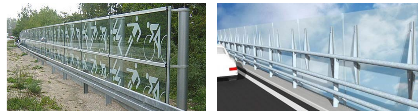
Figur 15. Eksempel på transparente skjerm og på grafisk utsmykning med silketrykk på transparent skjerm. Til venstre vises eksempel på støyskjerming med glass på bru.
