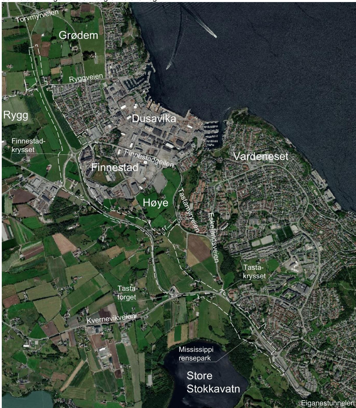
Figur 2-1 Plangrense for E39 Smiene – Harestad er markert med stiptet linje. Kilde: planbeskrivelsen, Norconsult.
