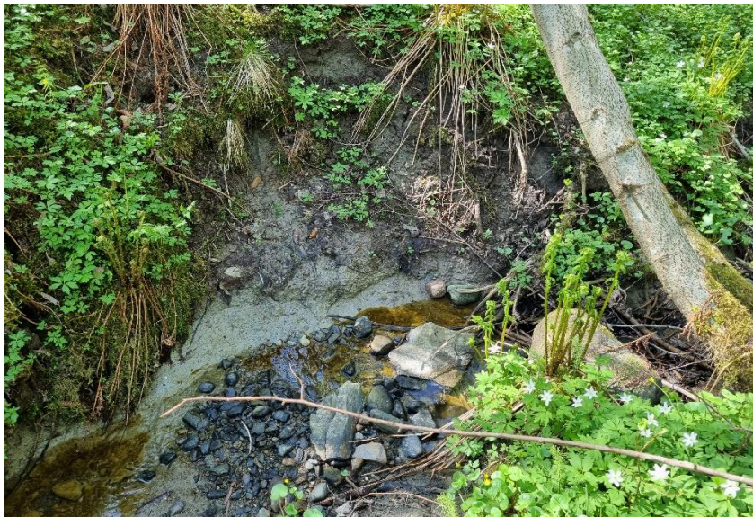
Figur 3-20: viser erosjon og leire i bekkeforgreiningen lengst nord i skogsområdet ved Tonstad/Sjetnemarka. Foto: Sweco
