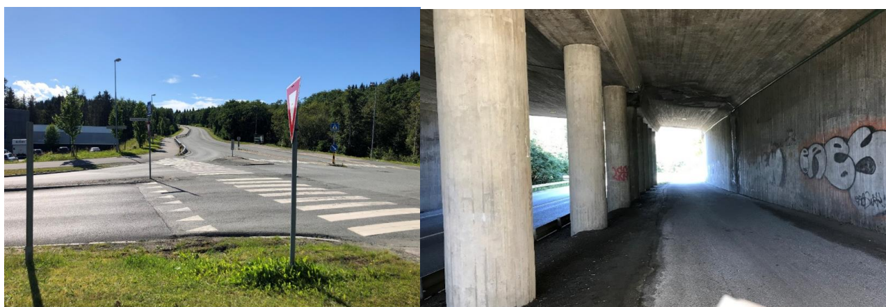
Figur 4-5: Over til venstre: Krysset Fossestuvegen x Gamle Okstadbakkan. Over til høyre: Eksisterende undergang under E6. Gang-/sykkelvegen har en bredde på 4,6 m.
