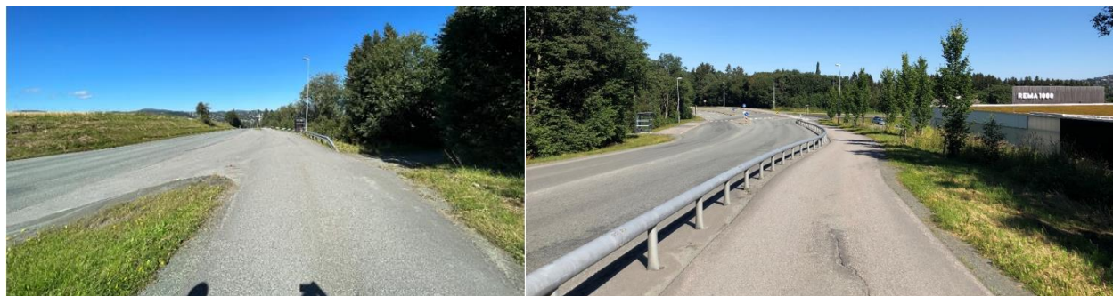
Figur 4-4: Dagens gang- og sykkelveg sett mot nord. Okstad holdeplass nordgående retning til høyre i bildet. Bildet til høyre viser gangsykkelveg parallellt med kjøreveg. REMA 1000 synes i enden av strekningen.
