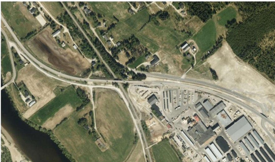
Figur 4 Flyfoto av dagens situasjon. (Kilde: NVE, Atlas)
