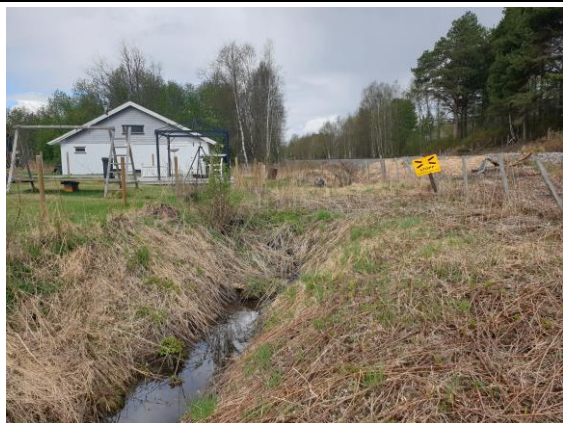
Bilde 1 - sidegrøft langs Rørosbanen nord for rv. 3
