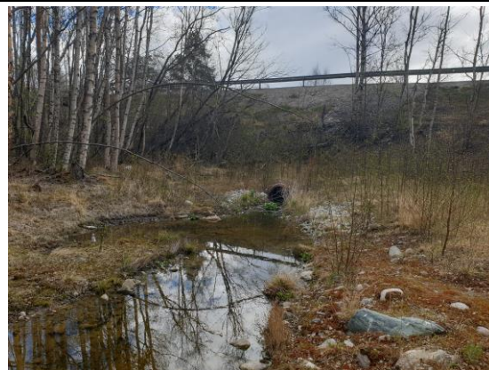
Bilde 2 - fordrøyningsvolum og gjennomløp under rv. 3
