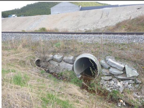
Bilde 5 - utløp av Ø1600 mm kulvert under Rørosbanen
