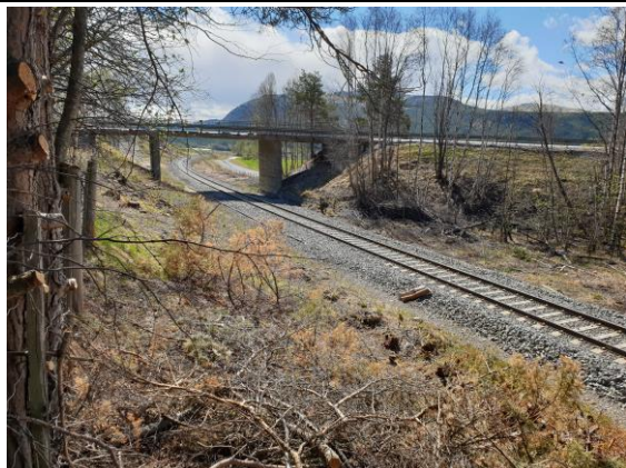
Bilde 3 - eksisterende bru over Rørosbanen sett fra nord
