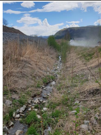
Bilde 6 - sidegrøft på vestsiden av Rørosbanen sørover fra utløp av Ø1600 mm kulvert
