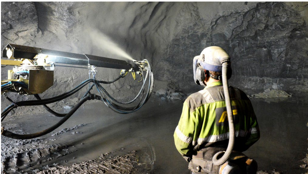
Figur 6: Påføring av sprøytebetong som fjellsikring under arbeidet med rv. 13 Ryfylketunnelen (foto: Øyvind Ellingsen, Statens vegvesen)
