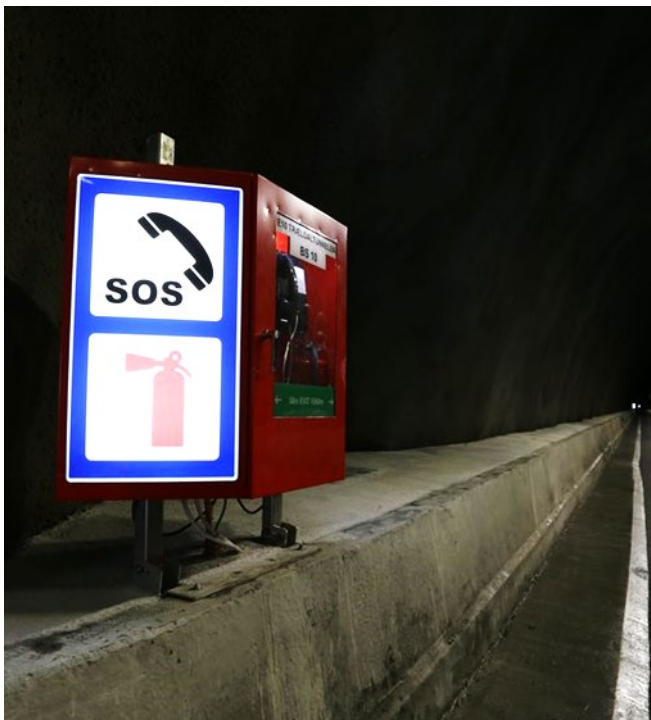
Til venstre: Nødstasjon etablert som skåp på tunnelveggen (foto: Tomas Rolland, Statens vegvesen).
