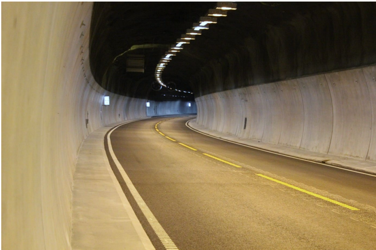
Figur 5: E16 Vangstunnelen er døme på ein tunnel som har 125 centimeter brei skulder. Tunnelen vart opna i 2013, men viss den hadde blitt bygd i dag skulle breidda vore 150 centimeter (foto: Marius Slinde, Statens vegvesen).
