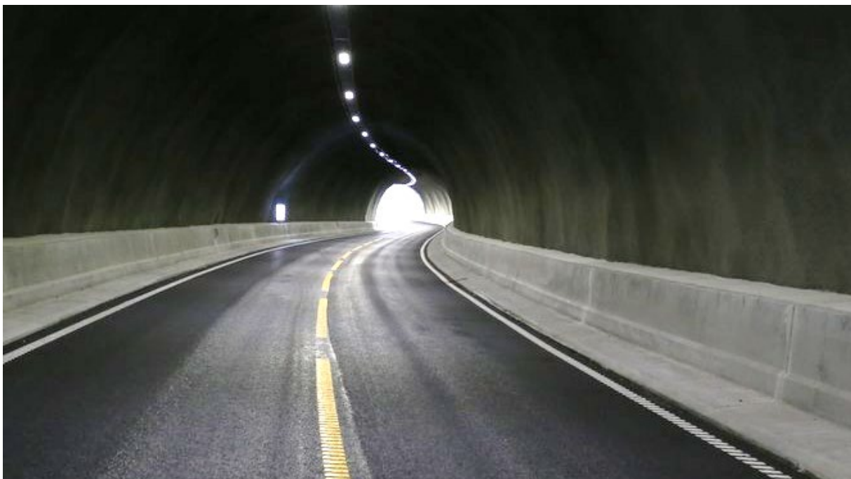
Figur 13: E10 Trældaltunnelen der det er montert skilt på nødstasjonen, i staden for overhengande skilt. Synlegheita for trafikantane er etter arbeidsgruppa si vurdering like god med denne løysinga. (Foto: Tomas Rolland, Statens vegvesen.)
