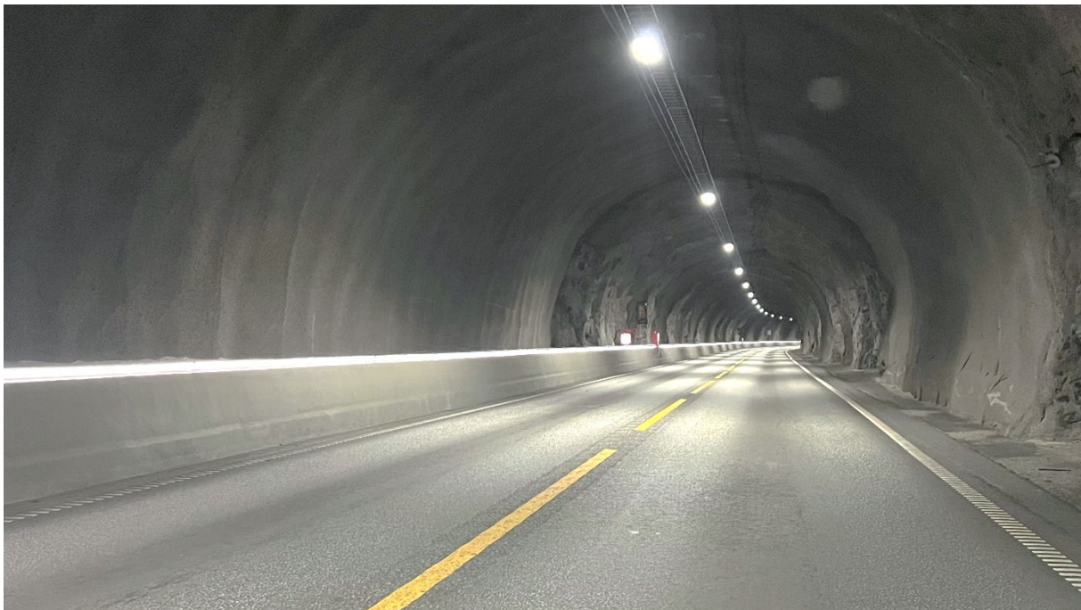
Figur 8: E16 Borgundstunnelen har føringskant på eine side, utan at det er heva skulder inn mot denne. Merk at i dette dømet er føringskanten einsidig og at skuldra er relativt smal fordi dette er gjort som del av tunneloppgradering. For nye
