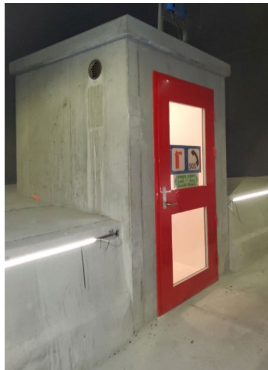
Til venstre: Nødstasjon etablert som skåp på tunnelveggen (foto: Tomas Rolland, Statens vegvesen).
