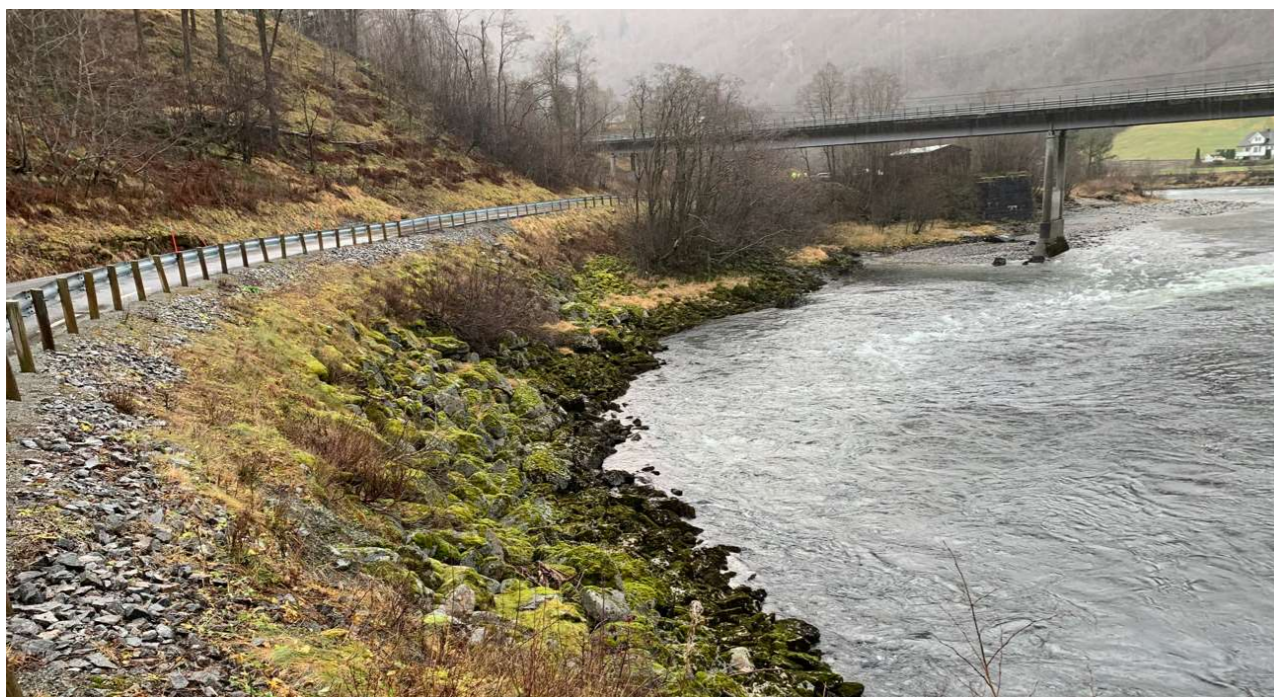
Figur 55. Elvebreddens preg med erosjonssikring i tilsvarende situasjon nedstrøms eksisterende bru, sett fra Hoåsvegen.
