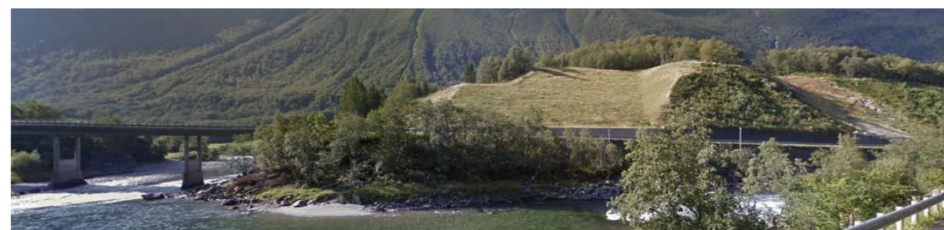
Figur 41. Dagen skråningen på vestsiden av brua
