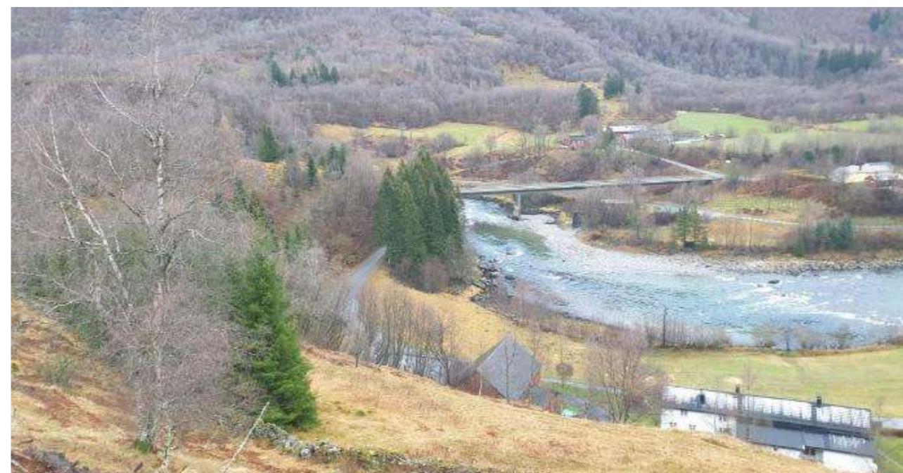
Figur 11. Selve dalbunnen med småkupert terreng før det stiger bratt opp til fjellet; Fale bru sett fra sør
