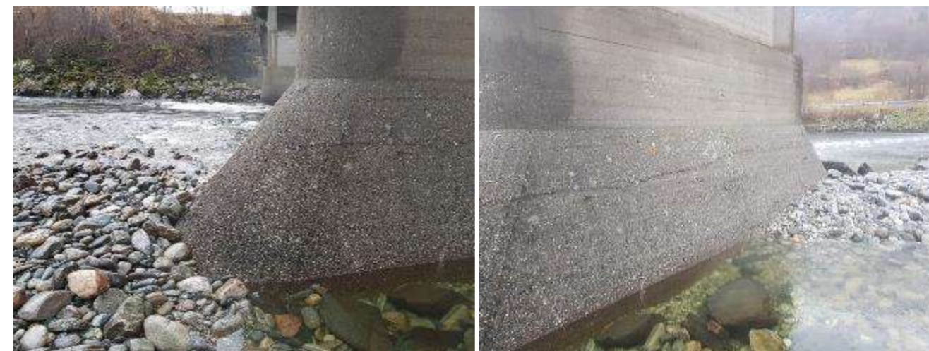
Figur 52. Eksisterende brupilarer som skal fjernes. Fundamenter som ikke skal rives vil ikke være synlige
