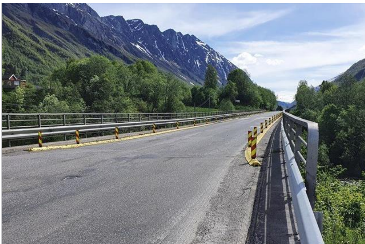
FIGUR 1 Eksisterende bru på rv. 70 ved Fale rives når ny bru er tatt i bruk. Foto hentet fra Statens vegvesens informasjonsside om prosjektet.
