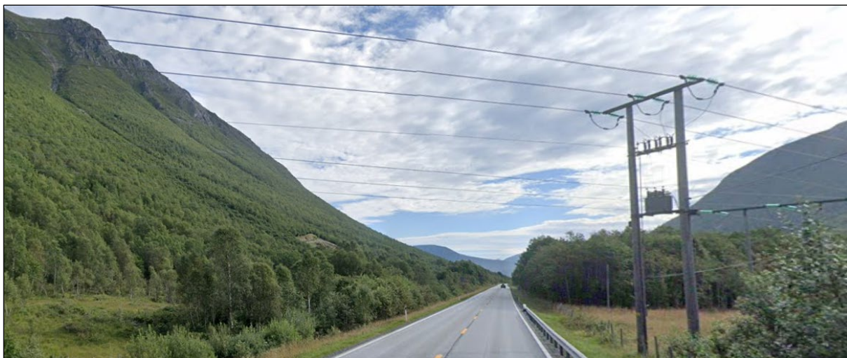
Figur 13 Massetak ved Ryggjefonna, sett nedover Skorgedalen, mot øst.
