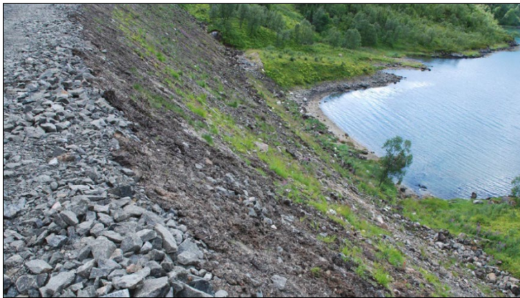
Figur 27 Erfaringsmessig er det hensiktsmessig å legge ut vegetasjonsdekke parallelt med oppbyggingen av større fyllinger. Terrengtilpasning og utlegging av vegetasjonsdekke utføres i en direkte forlengelse av berguttak, og før man forlater topp bergskjæring. Kilde: Statens vegvesen, foto fra E10 Lofast.
