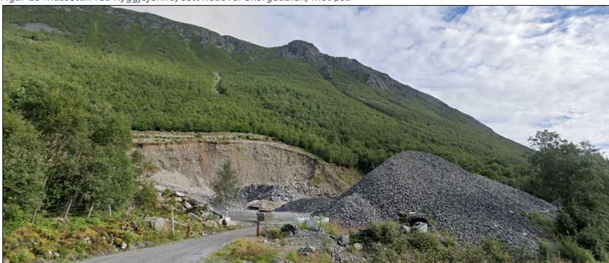
Figur 14 Massetak sett fra vegen.
