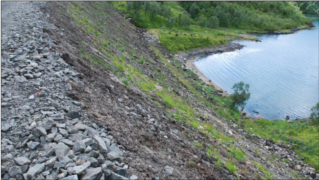
Figur 33 Erfaringsmessig er det hensiktsmessig å legge ut vegetasjonsdekke parallelt med oppbyggingen av større fyllinger. Terrengtilpasning og utlegging av vegetasjonsdekke utføres i en direkte forlengelse av berguttak, og før man forlater topp bergskjæring. Kilde: Statens vegvesen, foto fra E10 Lofast.
