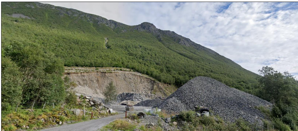
Figur 12 Massetak sett fra vegen
