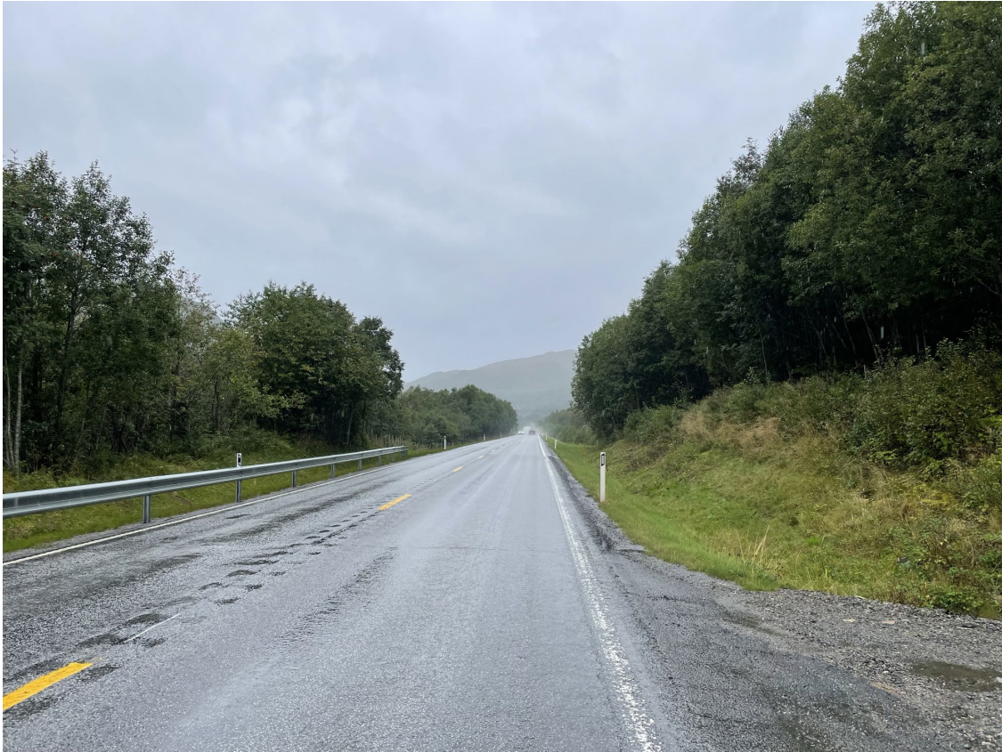
Figur 19 Dagens situasjon sett fra planområdet – ved grustaket. E39 har i dag samme trasé som Den Trondhjemske postvei, og historiske spor er borte. Foto Tine Eikehaug, Statens vegvesen.
