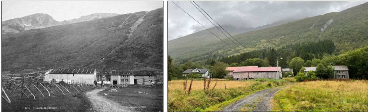
Figur 1 Skyssgården Ellingsgard fotografert sist på 1880-tallet av Knud Knudsen (eier av foto - UiB). Til høyre er dagens situasjon. Ellingsgården er et vernet kulturminne. Foto Tine Eikehaug, Statens vegvesen.
