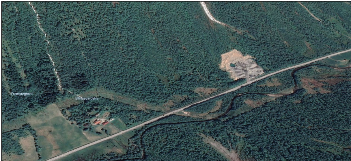
Figur 9 Massetaket sett fra luften. Området ligger rett ved E39/E136. Eksisterende sikringstiltak ligger sørvest for massetaket. Skorgeelva renner i bunn av dalen. Høyspentlinje ligger også i dalbunnen. Kilde: 3D fra Norge i bilder
