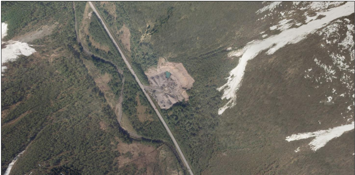
Figur 4 Ryggjefonna ligger inntil E136 på motsatt side av Skorgeelva. Bredde på vegetasjonsbelte langs elva bør fastsettes i reguleringsplanen.
