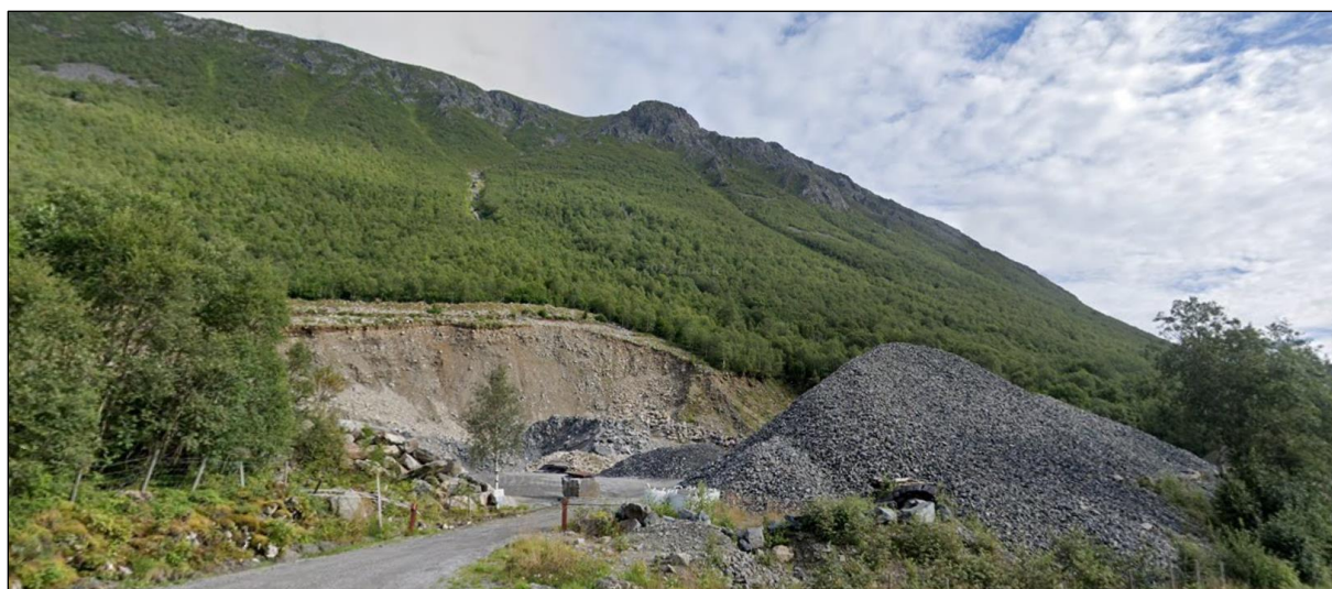
Figur 9. Massetak sett fra vegen.
