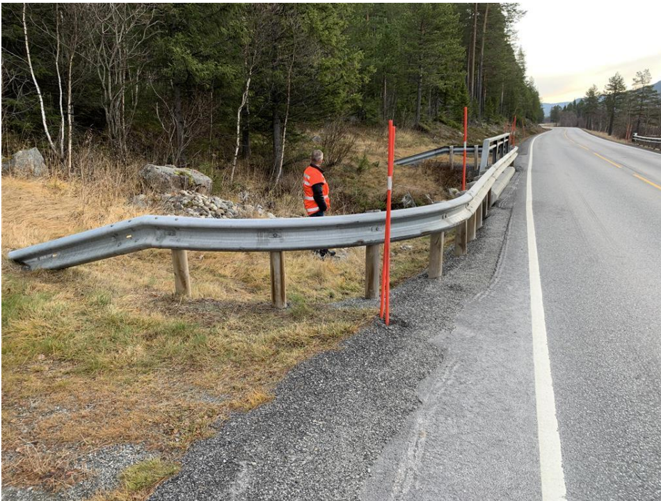
Figur 13. Oversiktsbilde av innløpet til Sandbekk bru. Foto: Statens vegvesen.
