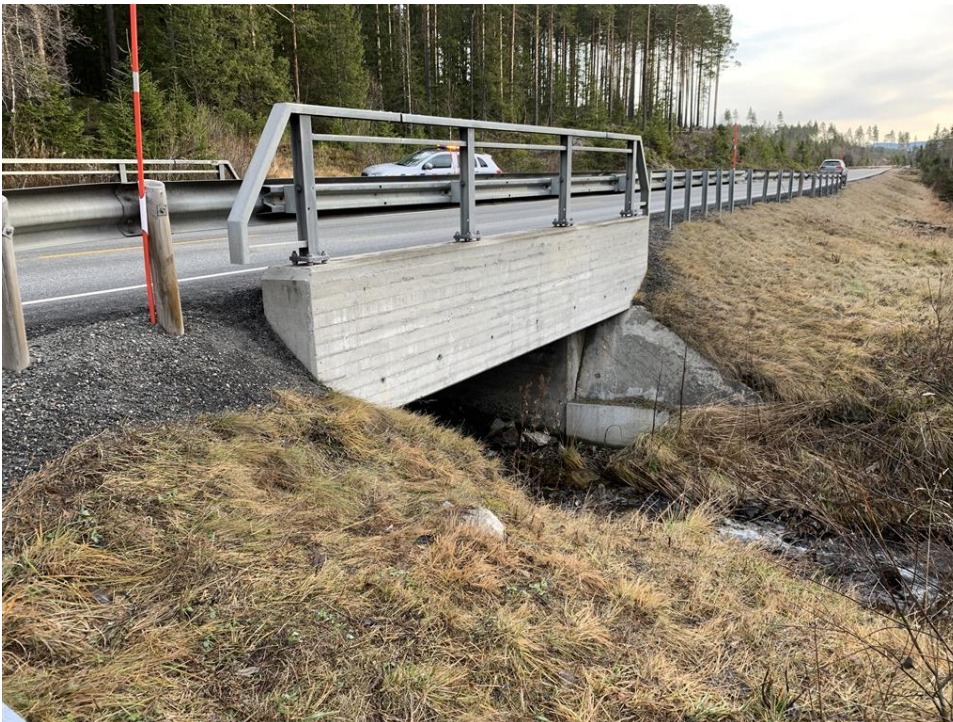
Figur 9. Bilde av utløpet til Gravset bru. Foto: Statens vegvesen.
