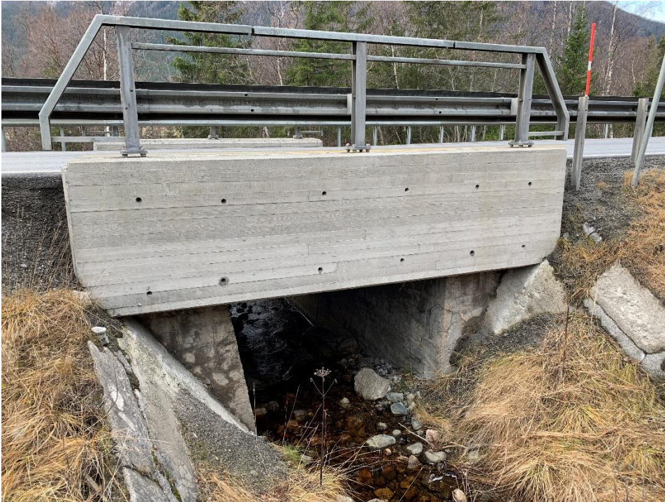
Figur 10. Bilde av innløpet til Skolt bru. Foto: Statens vegvesen.
