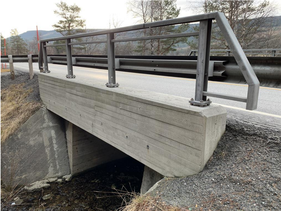
Figur 12. Bilde av innløpet til Sandbekk bru. Foto: Statens vegvesen.
