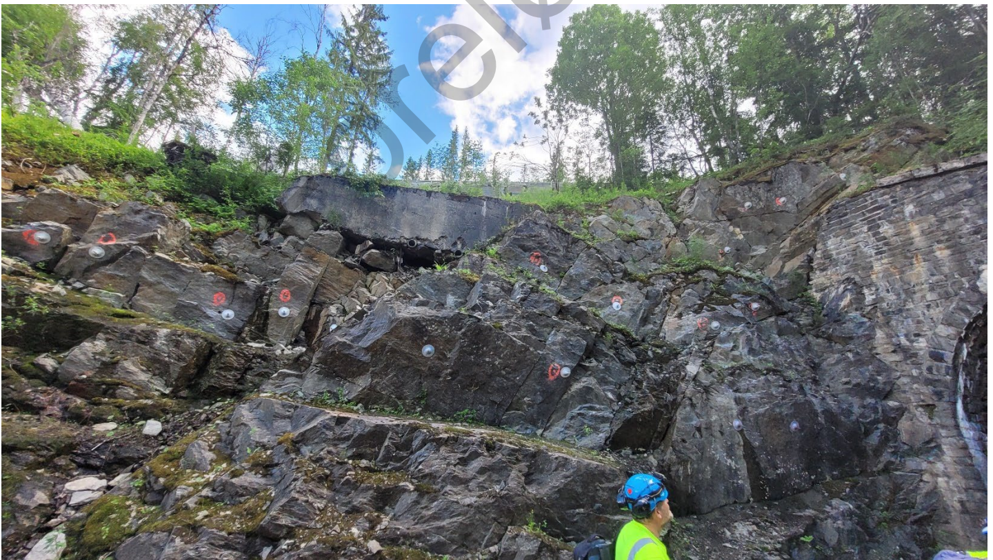
Foto 2: Gammel betongmur mellom jernbanen og eksisterende E6. Det er etablert en tørrmur inntil E6 i 2020.
