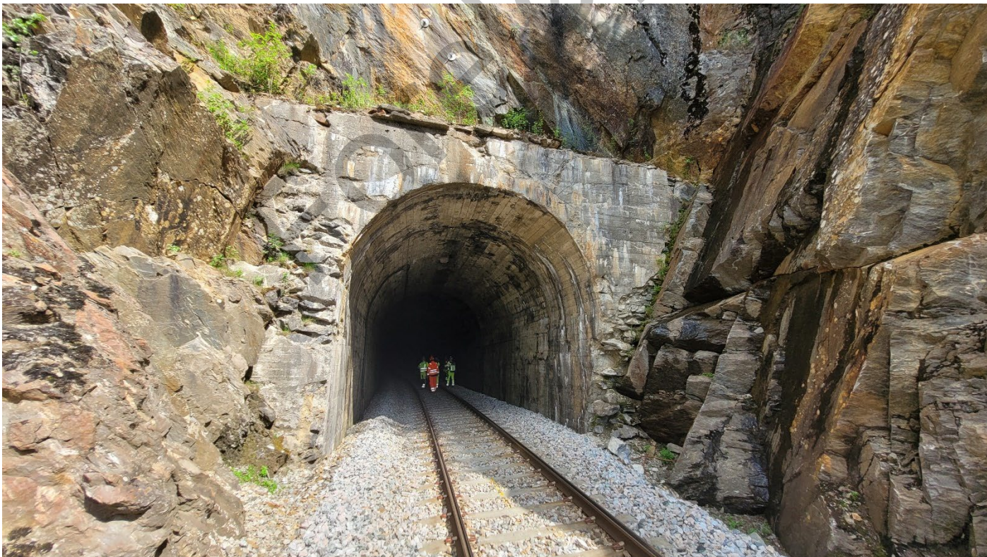
Foto 6: Sørlike tunnelinnslag m 279 383.
