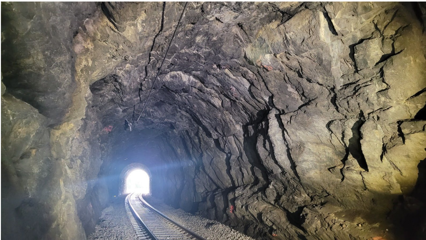
Foto 5: Foto tatt fra ca m 278 375 og mot nordre påhugg.
