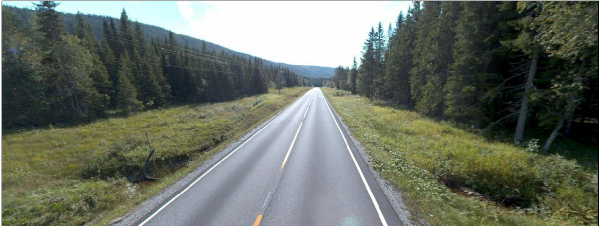
Figur 23 Bekk nord for Fossheim. Liten bekk der det er mer åpent ved stikkrenne. Ø450 mm. Sett mot sør. Vegtasjonsrydding på begge sider av E6 er tiltak for lettere å oppdage vilt og dermed unngå påkjørsler.
