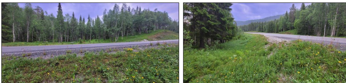
Figur 13 Stikkrenne for liten bekk, ser bekk i terrenget på bildet til høyre. Ikke potensial for fisk.
