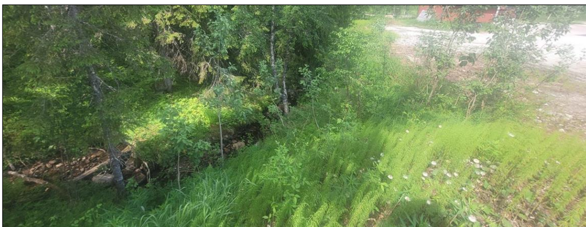
Figur 18 Bekk ved Fossheim rett ved E6. Stikkrenne Ø1000 mm. Mulig fiskeførende.
