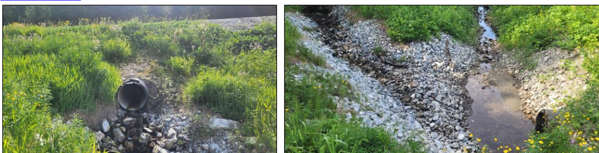
Figur 17 Strekningen sør for Fossheim har flere bekker, men ingen har potensial for fisk. Bilder viser inn- og utløp av samme bekk sør for snuplass. Ø450. Samme bekk som ses på vegbilde i figur over.
