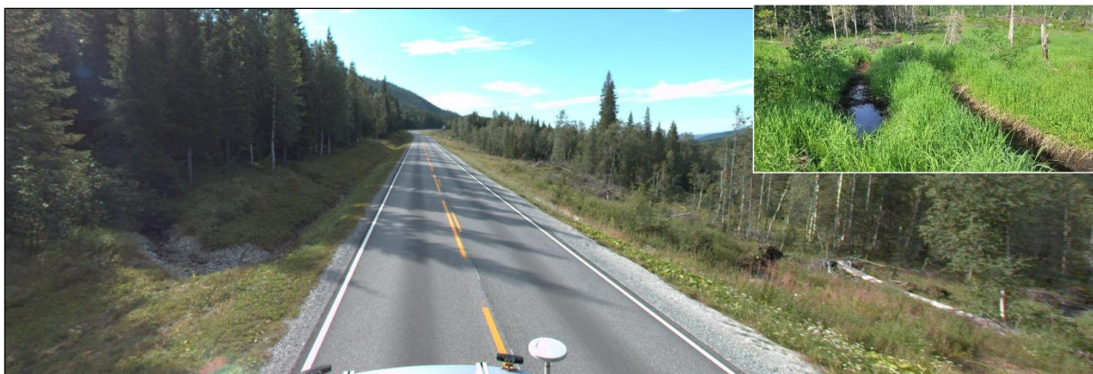
Figur 16 E6 sør for Fossheim, sett mot sør. Skader etter skogsdrift (innfelt bilde). Kilde: Vegbilder (vegvesen.no)
