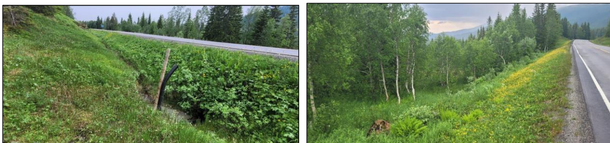
Figur 12 Liten bekk som krysser E6 fra høyereliggende terreng i øst. På vestside av E6 er det myr.
