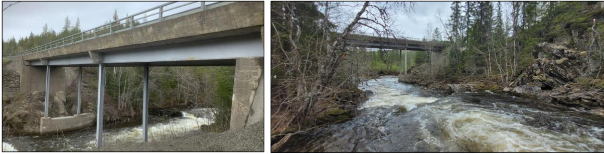
Figur 3 Dagens bru sett nedstrøms til venstre. Til høyres ses ny bruplassering oppstrøms.
