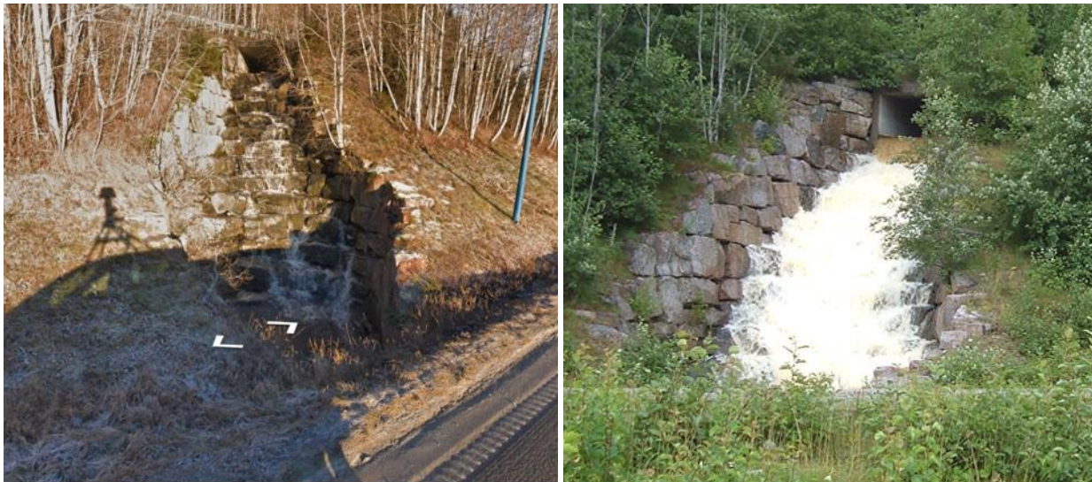
Figur 44 Eksempel på steinsatt renne
