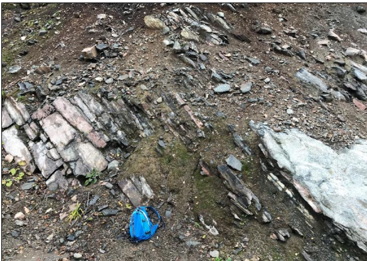
Figur 70 Del av svakhetssone i bergskjæring ovenfor Tomrefjord (sett mot øst). Foto Statens vegvesen.
